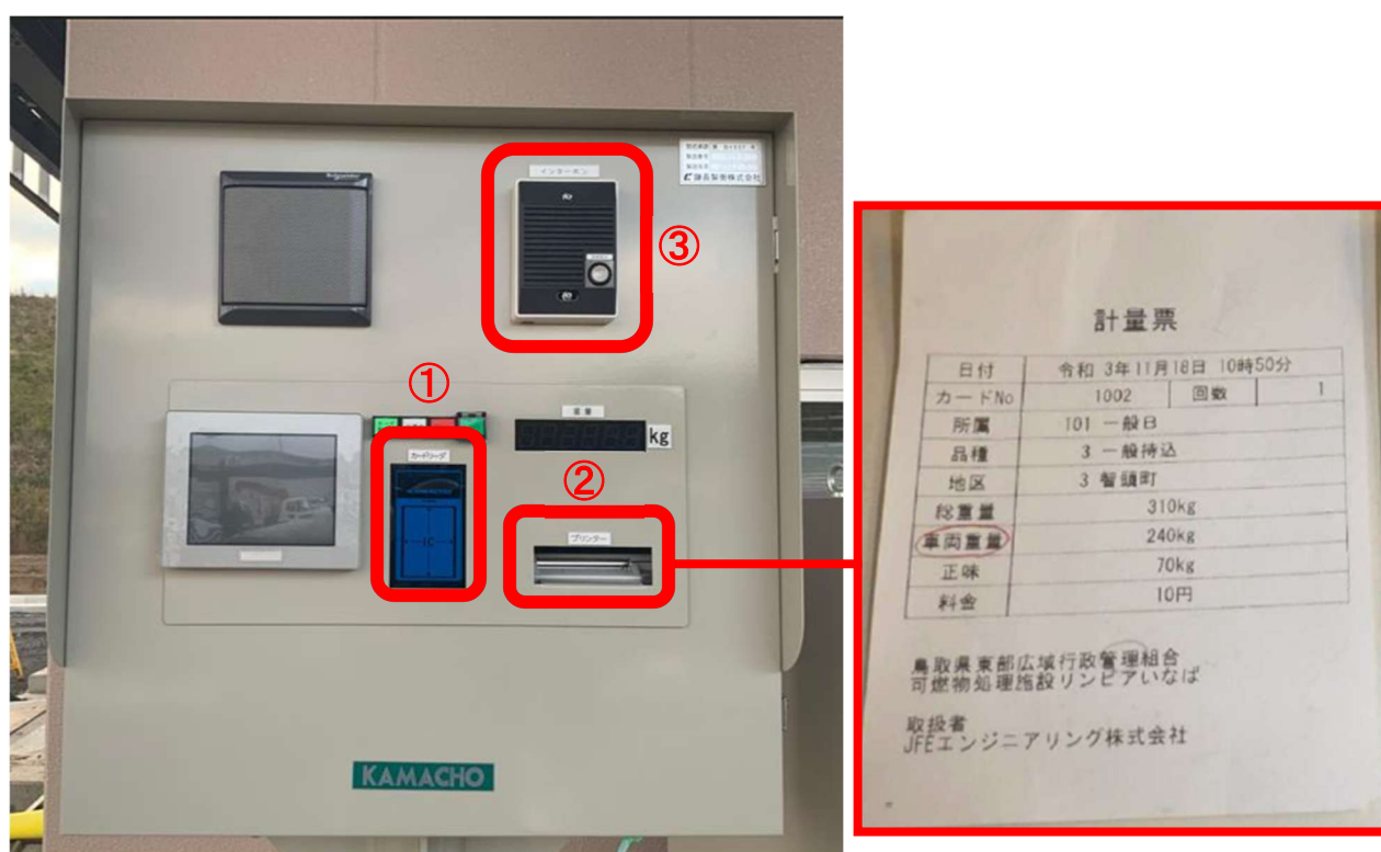
図 9 カードリーダー盤
